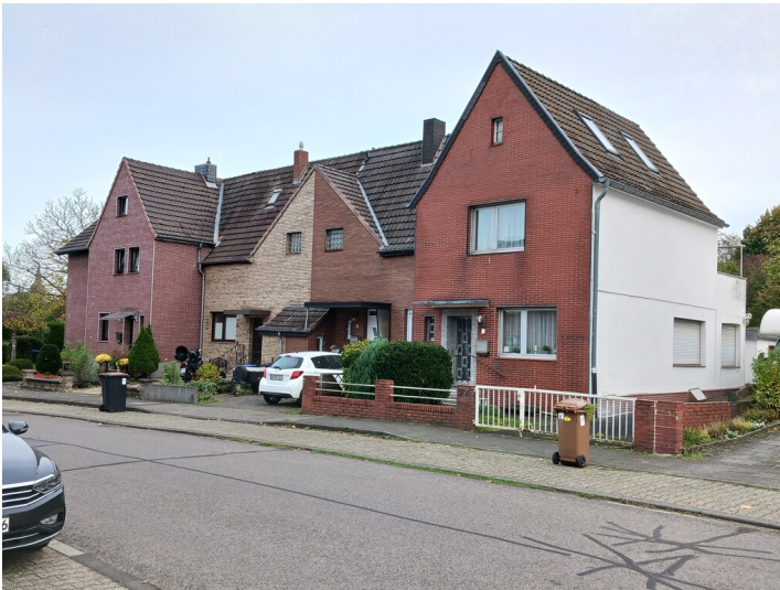
Brühl, Werkssiedlung Heide, Typ 2 (Endhaus), 31.10.2022 Fotograf/Urheber: Dr. Alexander Kierdorf
