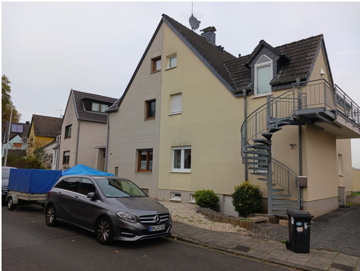
Brühl-Heide, Giebeldoppelhaus, Typ1, Barbarastraße, 13.9.2022 Fotograf/Urheber: Dr. Alexander Kierdorf
