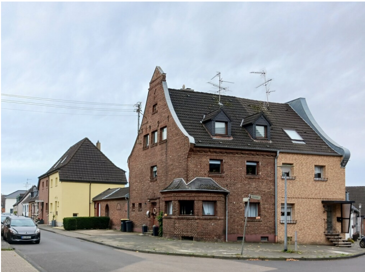
Köttingen, ehem. Ledigenheim, Blick von Norden, 5.11.2022 Fotograf/Urheber: Dr. Alexander Kierdorf
