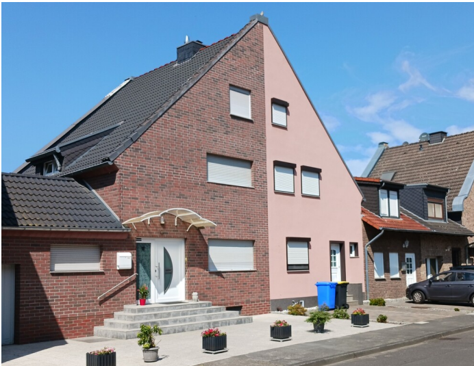
Köttingen, Giebeldoppelhaus Typ F1, Hermann-Köster-Straße 10-12, 11.7.2023 Fotograf/Urheber: Dr. Alexander Kierdorf
