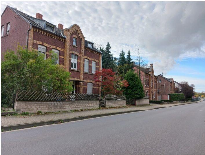
Inden-Lucherberg, Doppelwohnhäuser der Grube und Brikettfabrik, 5.11.2022 Fotograf/Urheber: Dr. Alexander Kierdorf
