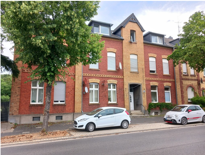
Brüggeln, Ehemaliges Werkskasinio Hubertus, Blick von Südwesten, 18.7.2023 Fotograf/Urheber: Dr. Alexander Kierdorf
