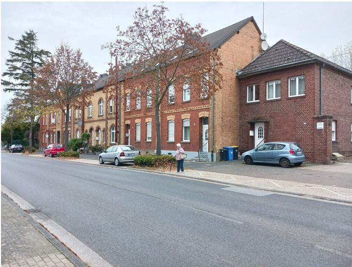
Brüggen, Heerstraße 351-361, Blick von Süden, 3.11.2022 Fotograf/Urheber: Dr. Alexander Kierdorf
