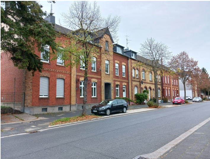
Brüggan, Werkssiedlung Hubertus, Blick von Westen, 3.11.2022 Fotograf/Urheber: Dr. Alexander Kierdorf
