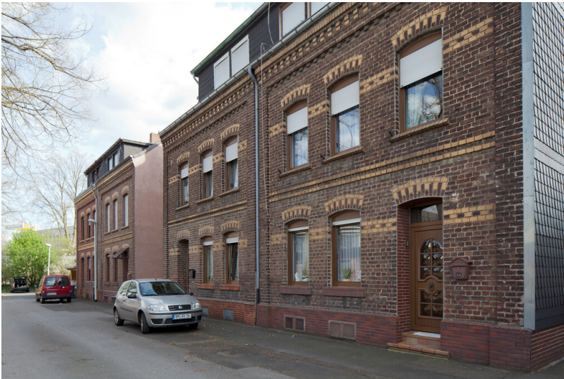
Frechen, Werkssiedlung Clarenberg, Hochstedenstraße, Schrägansicht von Westen, 3.1.2023 Fotograf/Urheber: Dr. Alexander Kierdorf
