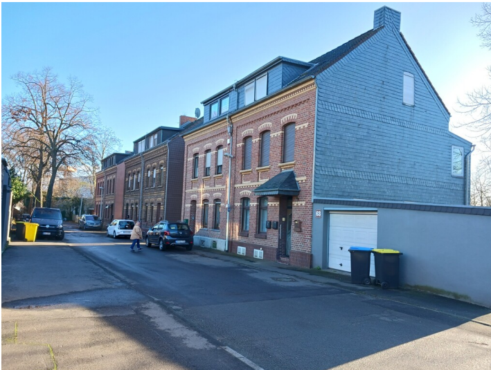
Frechen, Siedlung Clarenberg, Straßenfront der Doppelhäuser Nr. 63/65, 67/69 und 71/73, Schrägansicht von Westen, 3.1.2023 Fotograf/Urheber: Dr. Alexander Kierdorf
