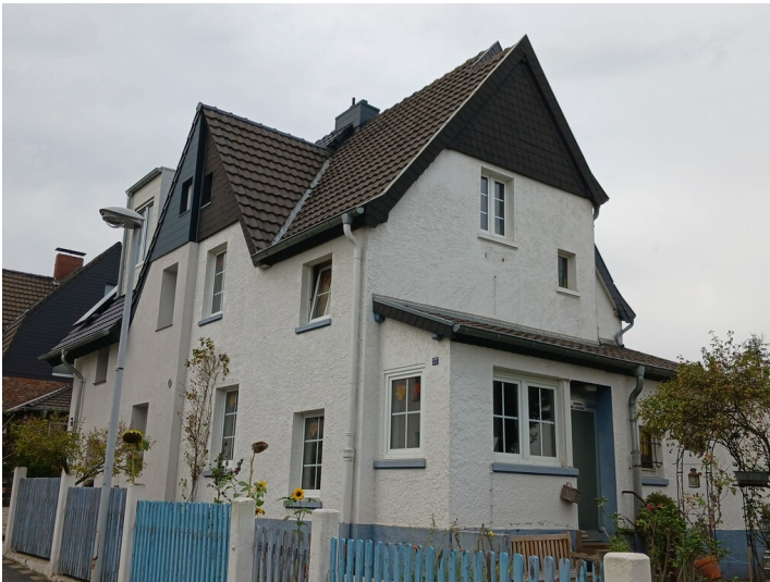
Brühl, Siedlung Kierberg/Gruhlwerk II, Doppelhaus Typ 1, 31.10.2022 Fotograf/Urheber: Dr. Alexander Kierdorf
