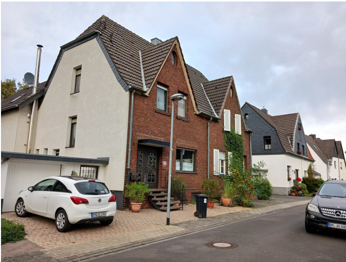
Werkssiedlung Kierberg/Gruhl II., Haustyp 1, Blick von Süden, 31.10.2022 Fotograf/Urheber: Dr. Alexander Kierdorf
