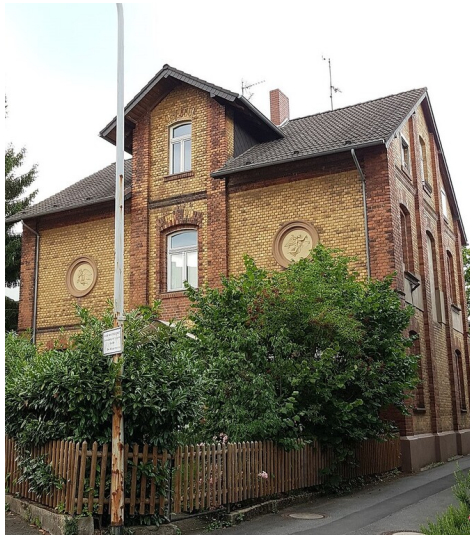
Brühl-Kierberg, ehem. Ledigenheim, Berrenrather Straße 30, 5.4.2023 Fotograf/Urheber: Dr. Alexander Kierdorf
