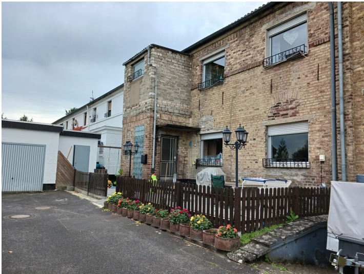
Brühl, Siedlung Vendel, Lohrbergstraße, Hausteile 1b-1i, 3.11.2022 Fotograf/Urheber: Dr. Alexander Kierdorf
