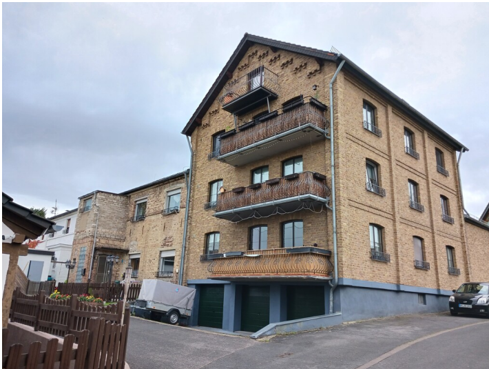
Brühl, Werkssiedlung Vendel, Kopfbau, Blick von Osten, 3.11.2022 Fotograf/Urheber: Dr. Alexander Kierdorf
