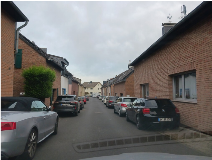
Brühl, Siedlung Ginsterhang/Roddergrube, Doppelhäuser beidseitig, 31.10.2022 Fotograf/Urheber: Dr. Alexander Kierdorf
