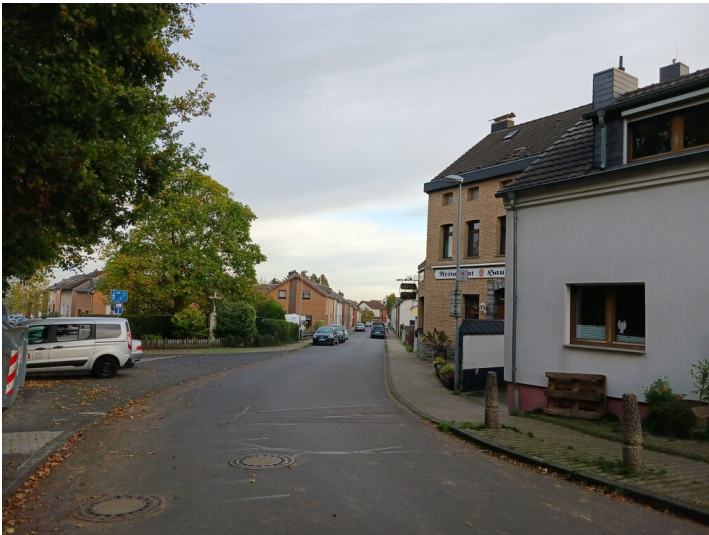
Brühl, Kolonie Pingsdorf, Blick von Westen auf Weggabelung, 31.10.2022 Fotograf/Urheber: Dr. Alexander Kierdorf
