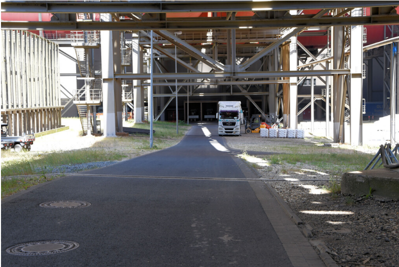
Kraftwerk Weisweiler: Straße "Am Kühler 14", Ansicht von Süden; Foto: 13.06.2023 Fotograf/Urheber: Dr. Norbert Gilson
