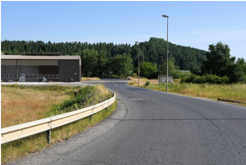
Kraftwerk Weisweiler: Am Kalkbahnhof, Ostabschnitt (im Hintergrund links der Kalkbahnhof), Ansicht von Süden; Foto: 16.06.2023 Fotograf/Urheber: Dr. Norbert Gilson
