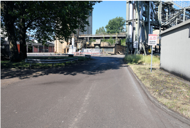
Kraftwerk Weisweiler: Laborstraße, Ansicht von Osten; Foto: 13.06.2023 Fotograf/Urheber: Dr. Norbert Gilson
