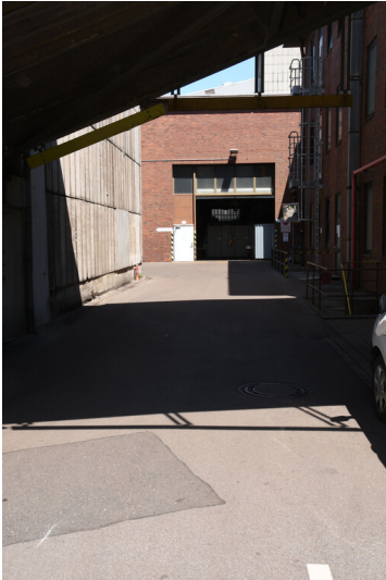
Kraftwerk Weisweiler: Lagerstraße, Abzweig von der Kantinenstraße, Ansicht von Süden; Foto: 13.06.2023 Fotograf/Urheber: Dr. Norbert Gilson
