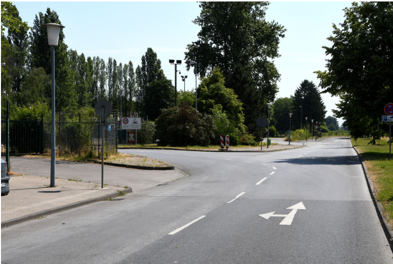
Kraftwerk Weisweiler: Werkstraße, Ansicht von Westen; Foto: 16.06.2023 Fotograf/Urheber: Dr. Norbert Gilson
