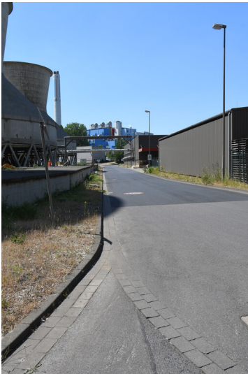
Kraftwerk Weisweiler: REA-Südstraße, in Richtung Lagergebäude 027 führend, Ansicht von Osten; Foto: 13.06.2023 Fotograf/Urheber: Dr. Norbert Gilson
