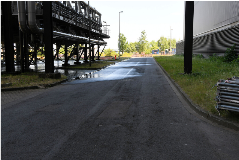
Kraftwerk Weisweiler: REA-Nordstraße, in Richtung Einmündung in die REA-Ringstraße verlaufend, Ansicht von Westen; Foto: 13.06.2023 Fotograf/Urheber: Dr. Norbert Gilson
