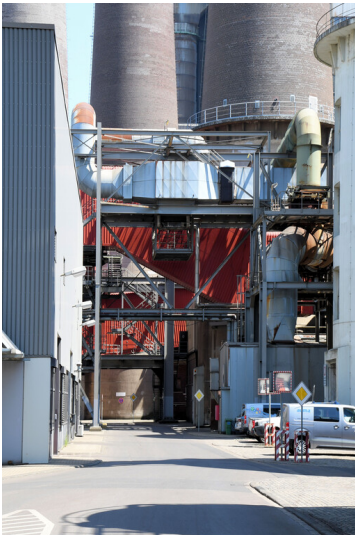
Kraftwerk Weisweiler: Kaminstraße, in Höhe der Werkstatt AEA an der Einmündung in die Hauptstraße, Ansicht von Westen; Foto: 13.06.2023 Fotograf/Urheber: Dr. Norbert Gilson
