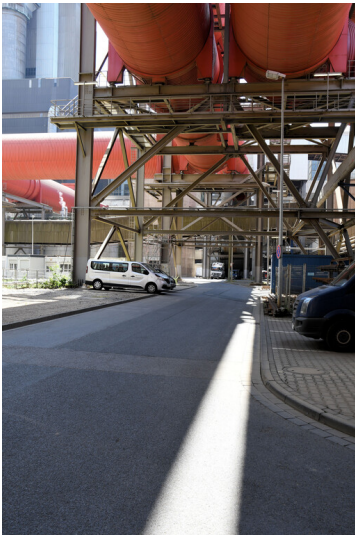
Kraftwerk Weisweiler: Brückenstraße, in Richtung Kaminstraße führend, Ansicht von Norden; Foto: 13.06.2023 Fotograf/Urheber: Dr. Norbert Gilson
