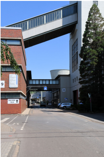
Kraftwerk Weisweiler: Hauptstraße, vor der E-Warte, Ansicht von Süden; Foto: 13.06.2023 Fotograf/Urheber: Dr. Norbert Gilson
