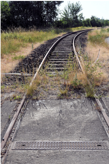
Kraftwerk Weisweiler: Zufahrtsgleis zum Kalkbahnhof (Kalkgleis), Ansicht von Nordwesten; Foto: 16.06.2023 Fotograf/Urheber: Dr. Norbert Gilson
