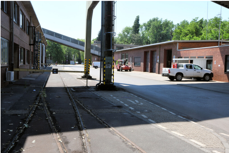
Kraftwerk Weisweiler: Zufahrtsgleis zum Lokschuppen westlich des Lagers, Ansicht von Norden; Foto: 13.06.2023 Fotograf/Urheber: Dr. Norbert Gilson
