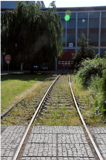
Kraftwerk Weisweiler: Trafogleis, in Richtung Durchfahrt durch die E-Warte führend, Ansicht von Westen; Foto: 13.06.2023 Fotograf/Urheber: Dr. Norbert Gilson
