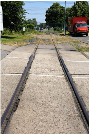
Kraftwerk Weisweiler: Zufahrtsgleis zum Kraftwerksgelände aus Richtung Frenz, Tor zum Kraftwerksgelände, Ansicht von Westen; Foto: 13.06.2023 Fotograf/Urheber: Dr. Norbert Gilson
