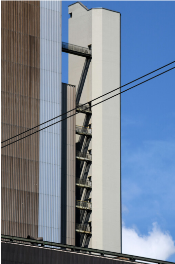
Kraftwerk Weisweiler: Fahrstuhl-Treppenhausturm Block H, Ansicht von Südwesten; Foto: 13.06.2023 Fotograf/Urheber: Dr. Norbert Gilson
