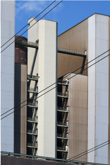
Kraftwerk Weisweiler: Fahrstuhl-Treppenhausturm Block G, Ansicht von Südwesten; Foto: 13.06.2023 Fotograf/Urheber: Dr. Norbert Gilson
