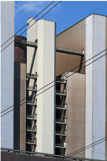
Kraftwerk Weisweiler: Fahrstuhl-Treppenhausturm Block G, Ansicht von Südwesten; Foto: 13.06.2023 Fotograf/Urheber: Dr. Norbert Gilson
