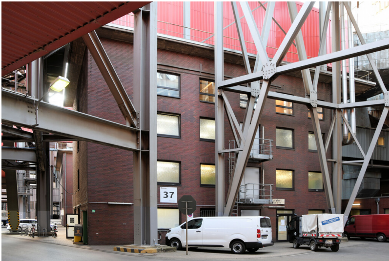
Kraftwerk Weisweiler: Sozialgebäude 3, Ansicht von Westen; Foto: 16.06.2023 Fotograf/Urheber: Dr. Norbert Gilson
