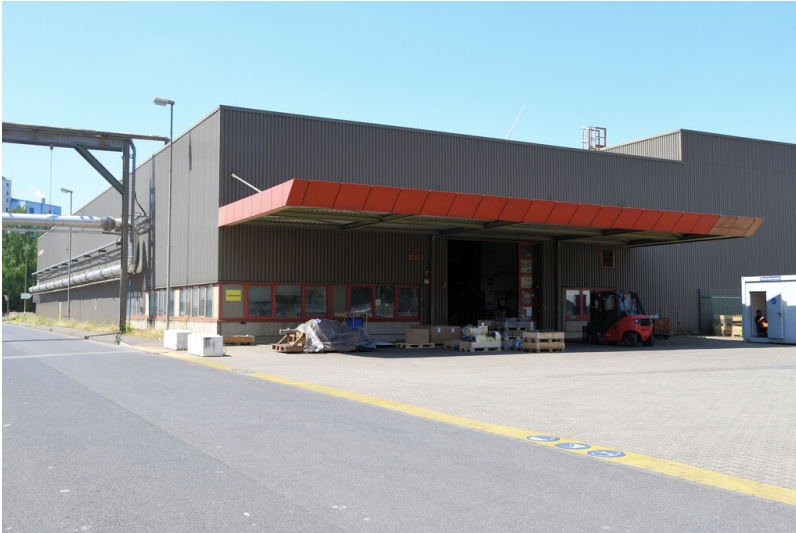
Kraftwerk Weisweiler: Lager 027, südlicher Hallenbau mit Warenannahme, Ansicht von Osten; Foto: 13.06.2023 Fotograf/Urheber: Dr. Norbert Gilson
