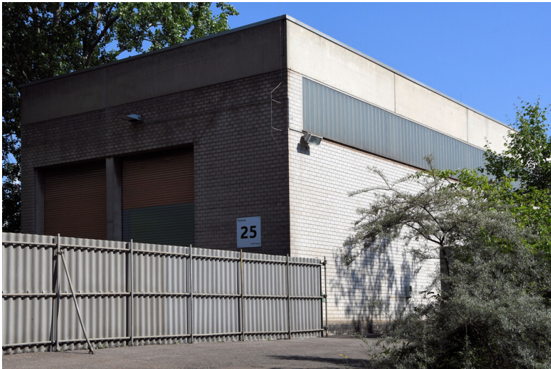
Kraftwerk Weisweiler: Lokschuppen, Ansicht von Süden; Foto: 13.06.2023 Fotograf/Urheber: Dr. Norbert Gilson
