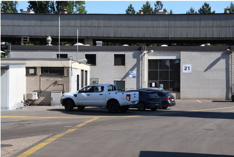
Kraftwerk Weisweiler: Bauhof, Ansicht von Süden; Foto: 13.06.2023 Fotograf/Urheber: Dr. Norbert Gilson
