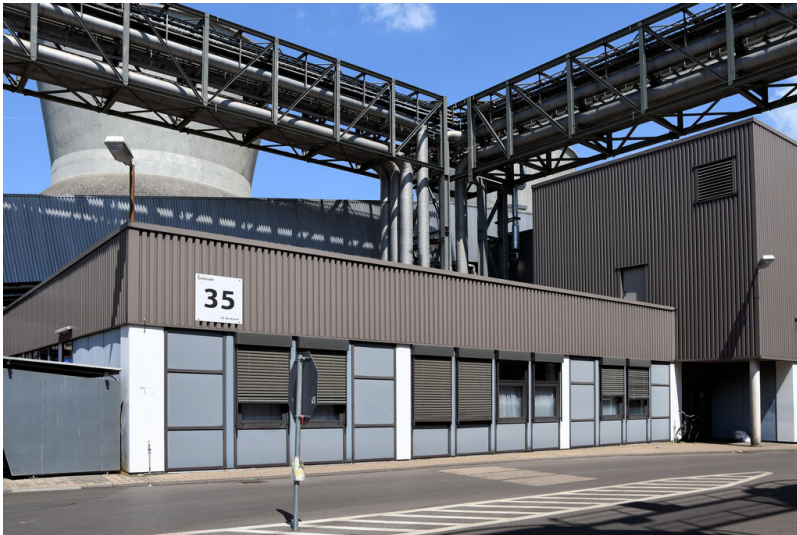
Kraftwerk Weisweiler: Werkstatt AEA, westlicher Flachbau, Ansicht von Südwesten; Foto: 13.06.2023 Fotograf/Urheber: Dr. Norbert Gilson
