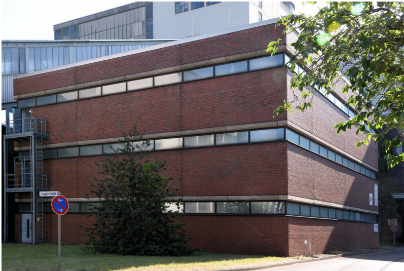
Kraftwerk Weisweiler: Sozialgebäude 2, Ansicht von Südwesten; Foto: 13.06.2023 Fotograf/Urheber: Dr. Norbert Gilson
