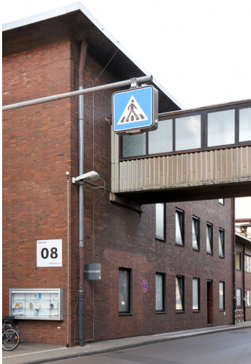
Kraftwerk Weisweiler: Sozialgebäude 1 (ehemals Waschkaue), Fußgängerbrücke zum Kesselhaus Block A, Ansicht von Süden; Foto: 16.06.2023 Fotograf/Urheber: Dr. Norbert Gilson
