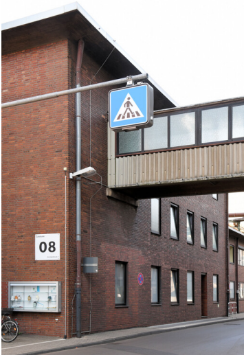
Kraftwerk Weisweiler: Sozialgebäude 1 (ehemals Waschkaue), Fußgängerbrücke zum Kesselhaus Block A, Ansicht von Süden; Foto: 16.06.2023 Fotograf/Urheber: Dr. Norbert Gilson
