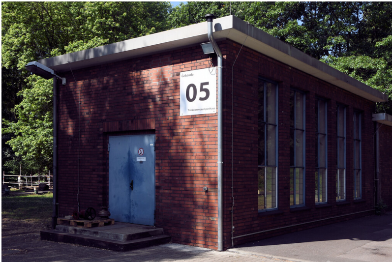
Kraftwerk Weisweiler: Pumpenhaus der ehemaligen Trinkwasseranlage, Ansicht von Nordosten; Foto: 16.06.2023 Fotograf/Urheber: Dr. Norbert Gilson
