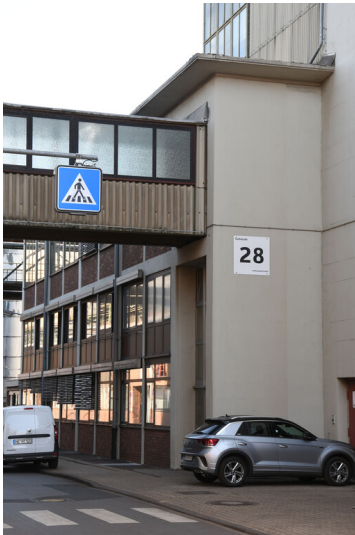
Kraftwerk Weisweiler: Auftragsleitstelle, Ansicht von Südwesten; Foto: 16.06.2023 Fotograf/Urheber: Dr. Norbert Gilson
