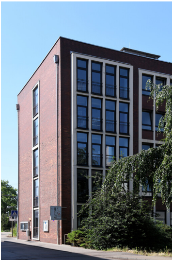
Kraftwerk Weisweiler: Verwaltung (älterer Gebäudetrakt), Treppenhaustrakt, Ansicht von Nordosten; Foto: 16.06.2023 Fotograf/Urheber: Dr. Norbert Gilson
