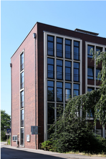
Kraftwerk Weisweiler: Verwaltung (älterer Gebäudetrakt), Treppenhaustrakt, Ansicht von Nordosten; Foto: 16.06.2023 Fotograf/Urheber: Dr. Norbert Gilson
