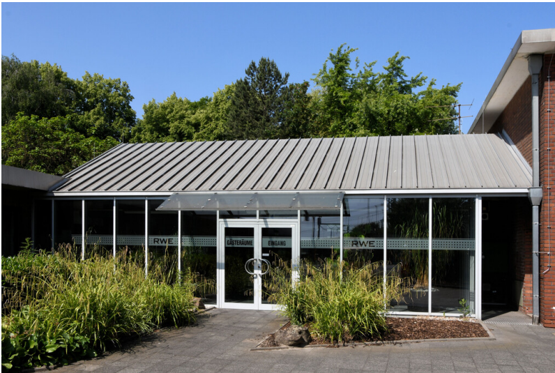
Kraftwerk Weisweiler: Kantine, Eingangshalle, Ansicht von Osten; Foto: 16.06.2023 Fotograf/Urheber: Dr. Norbert Gilson
