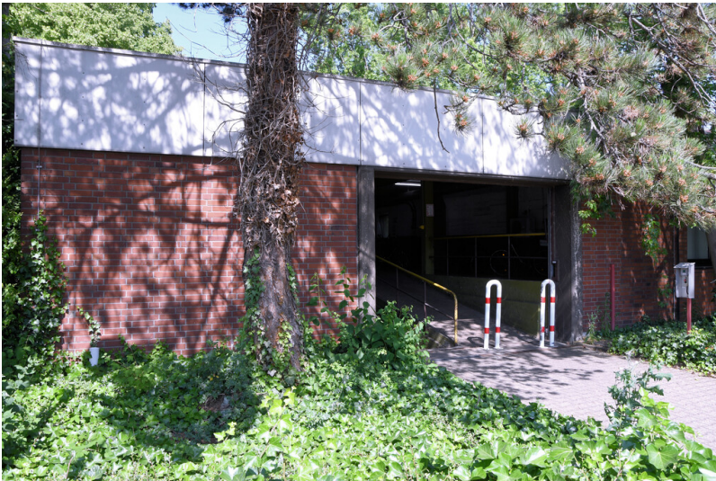
Kraftwerk Weisweiler: Fahrradschuppen, Zufahrt, Ansicht von Südosten; Foto: 16.06.2023 Fotograf/Urheber: Dr. Norbert Gilson
