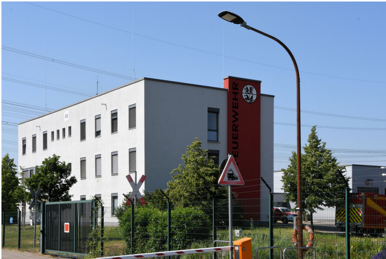
Kraftwerk Weisweiler: Neue Feuerwache, Verwaltungs- und Bereitschaftsgebäude, Ansicht von Nordosten; Foto: 16.06.2023 Fotograf/Urheber: Dr. Norbert Gilson
