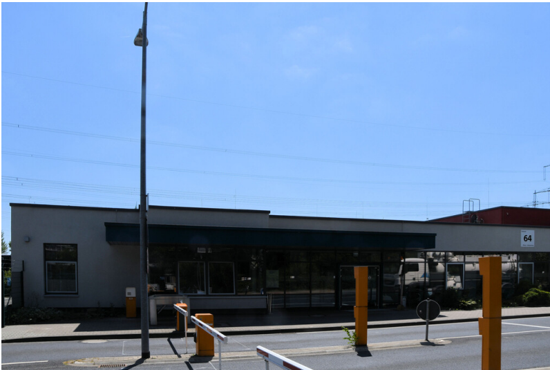
Kraftwerk Weisweiler: Pförtnergebäude, Eingangs- und Zufahrtsbereich, Ansicht von Norden; Foto: 13.06.2023 Fotograf/Urheber: Dr. Norbert Gilson
