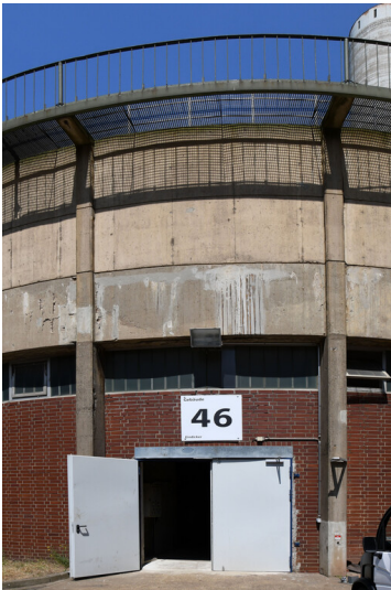
Kraftwerk Weisweiler: Schlammeindicker, Eingang, Ansicht von Süden; Foto: 13.06.2023 Fotograf/Urheber: Dr. Norbert Gilson
