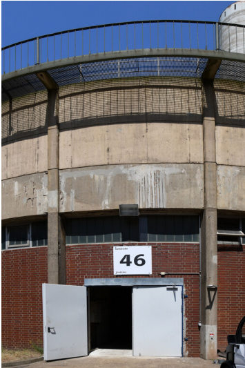
Kraftwerk Weisweiler: Schlammeindicker, Eingang, Ansicht von Süden; Foto: 13.06.2023 Fotograf/Urheber: Dr. Norbert Gilson
