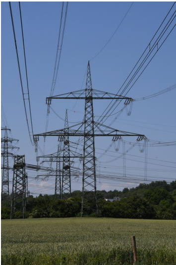
Kraftwerk Weisweiler: 380-kV-Freileitung (BI-Nr. 4514) zur Umspannanlage Oberzier, Ansicht von Osten; Foto: 16.06.2023 Fotograf/Urheber: Dr. Norbert Gilson
