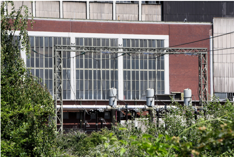
Kraftwerk Weisweiler: Freileitungsabgangsfeld Block F (380 kV), Abspannportal, Ansicht von Südwesten; Foto: 16.06.2023 Fotograf/Urheber: Dr. Norbert Gilson
